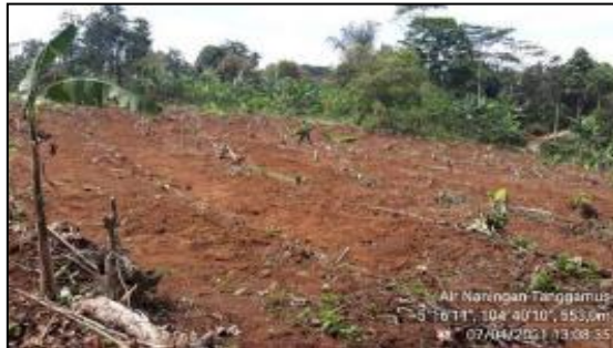
Kondisi lahan demplot setelah dilakukan pembuatan terrassing
