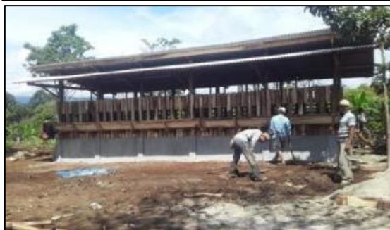
Kandang kambing sudah selesai dibangun, tampak muka
